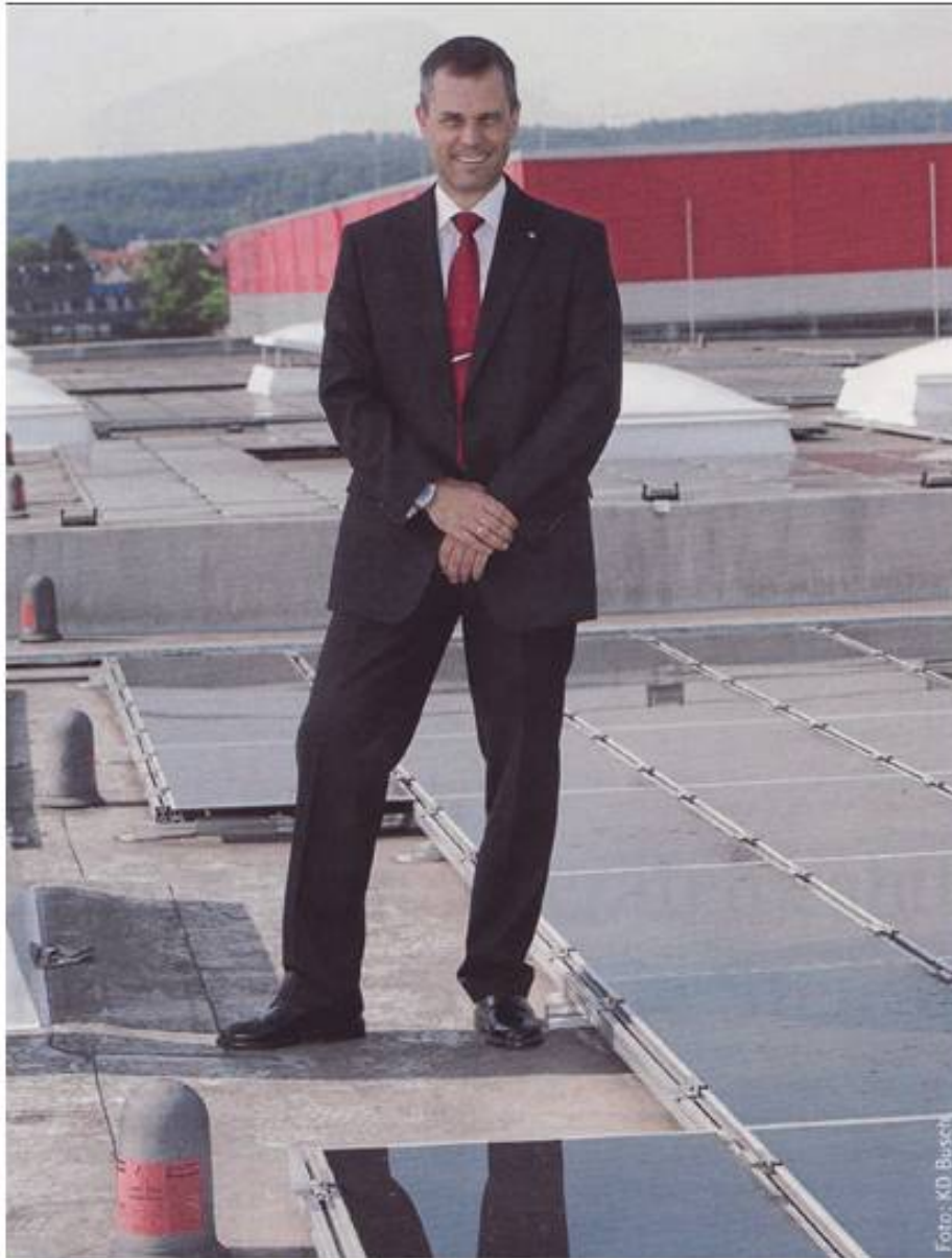
Auf dem Hallendach hat der Dienstleister LSU Schäberle eine Photovoltaik-Anlage installiert. Pro Jahr liefert sie 300 000 Kilowattstunden Strom, so Geschäftsführer Thomas Schäberle.
