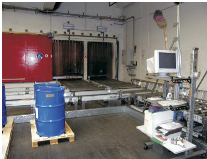
Unscheinbar, aber wichtig für LSU: Eingangsbereich des automatischen Oxy-Reduct-Hochregallagers für Gefahrstoffe
